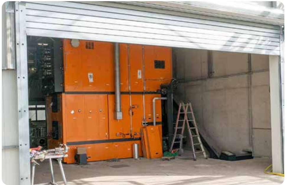
Mehrere Gewächshausbetriebe ersetzen ihre Heizungen durch eine Holzfeuerung.
