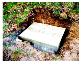
Fondazione costituita da più elementi di calcestruzzo
